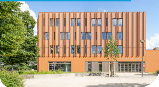
Centre de Mulhouse - La Maison de l'Industrie
